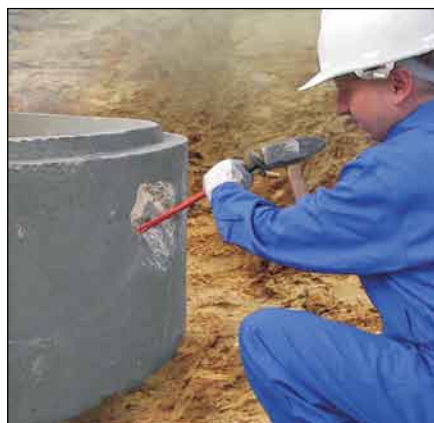
1) Napraviti otvor u betonskom oknu.
