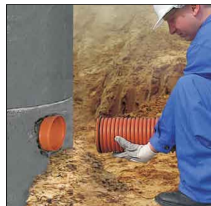
3) Spojiti cijev na umetak.
