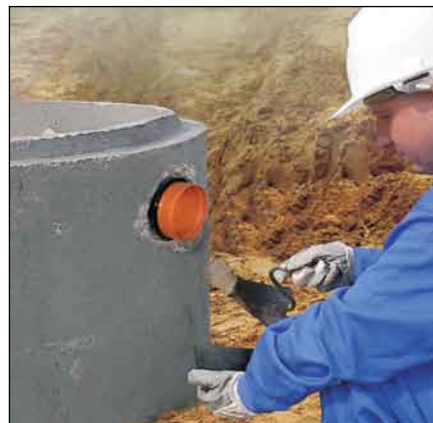
2) Ugraditi Pragma umetak.
